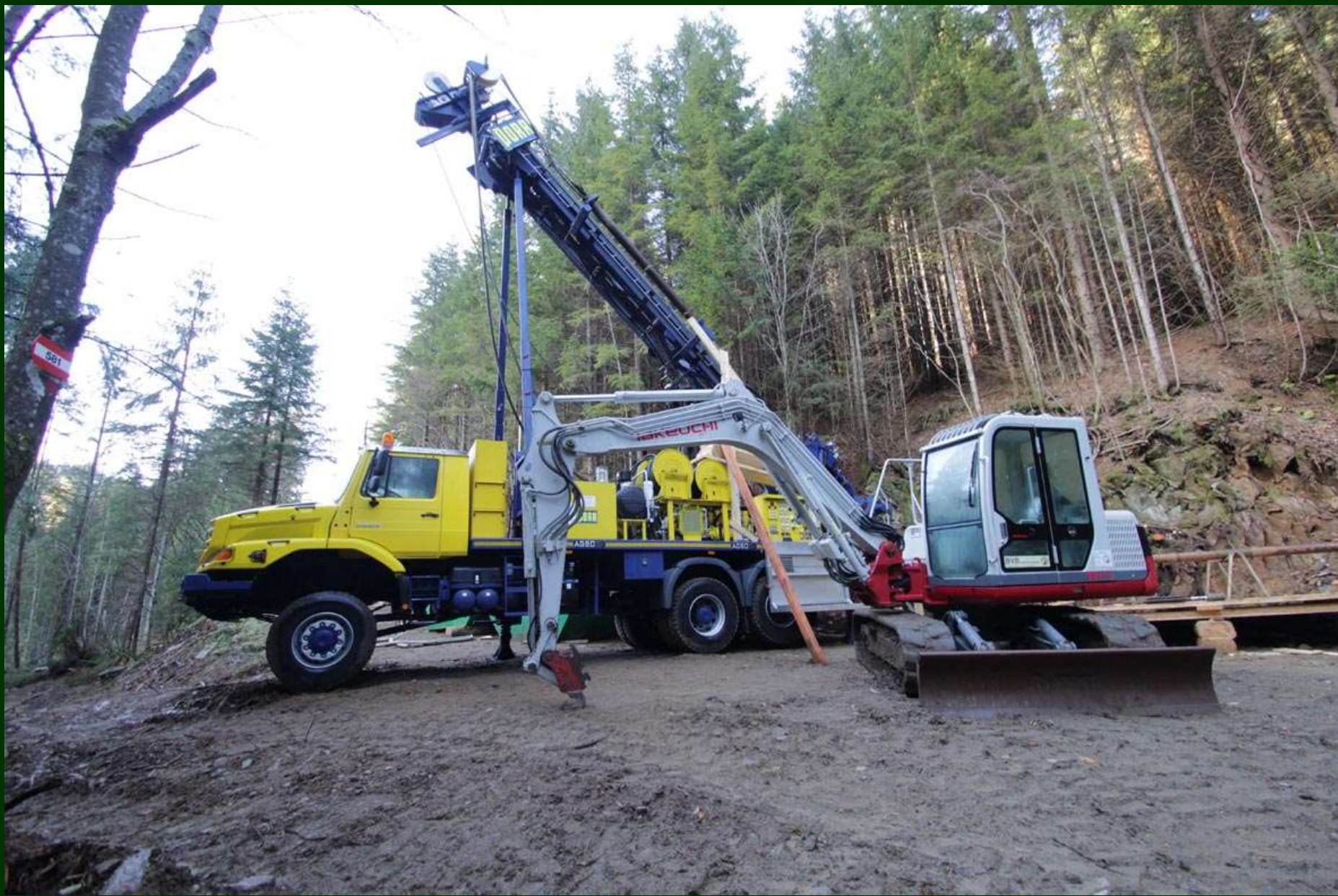
Probebohrungen im Bereich des Staudammes für den Unterspeicher Seebach 7.11.2013 WP
